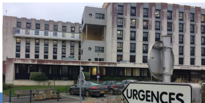
Façades avant le 1 er traitement
