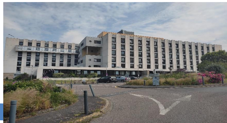
Façades après traitement par drone
